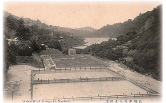
長崎本河内水源地
